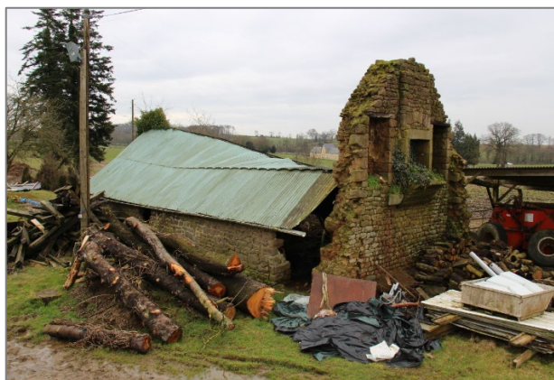
Figure 7 : exemple de bâtiment non recensé – Ruine à Ernée
