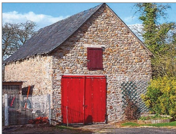
Figure 6 : exemple de bâtiment recensé - Saint-Hilaire-du-Maine
