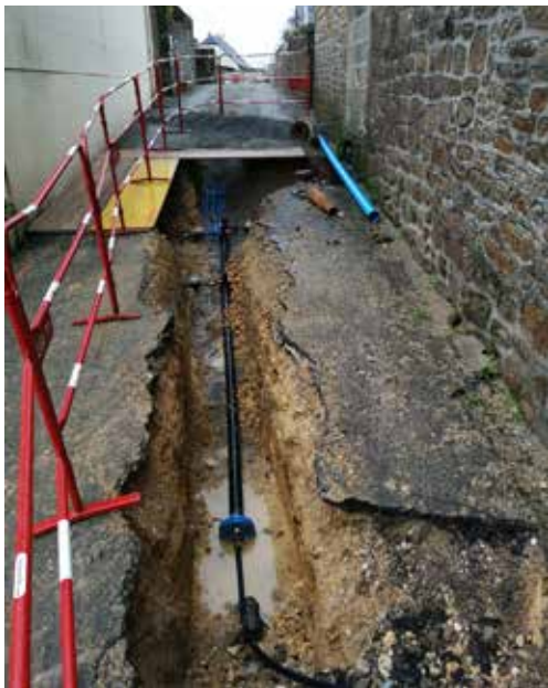
St Denis de Gastines Rénovation du réseau d'eau potable
