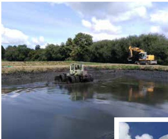
Vautorte Curage de la lagune, 880 m 3 de boues épandues sur 15,3 ha.
