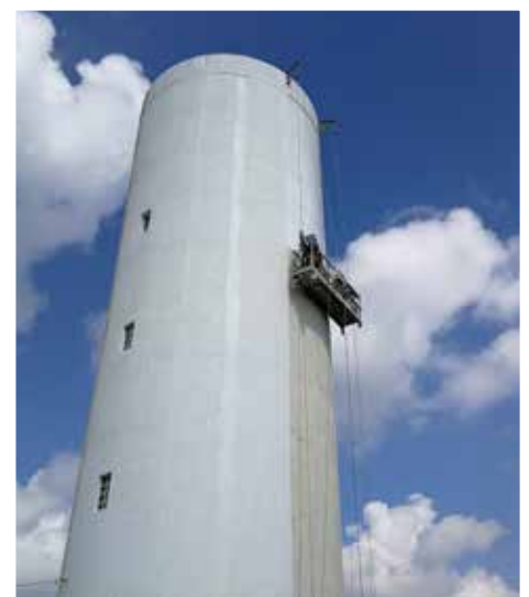
Montenay Réhabilitation du réservoir de la Jobryère
