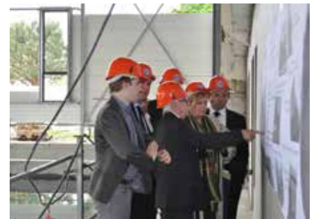
Impliqué au plus près des dossiers de la CCE, ici en présentation du chantier de réhabilitation de la piscine communautaire
