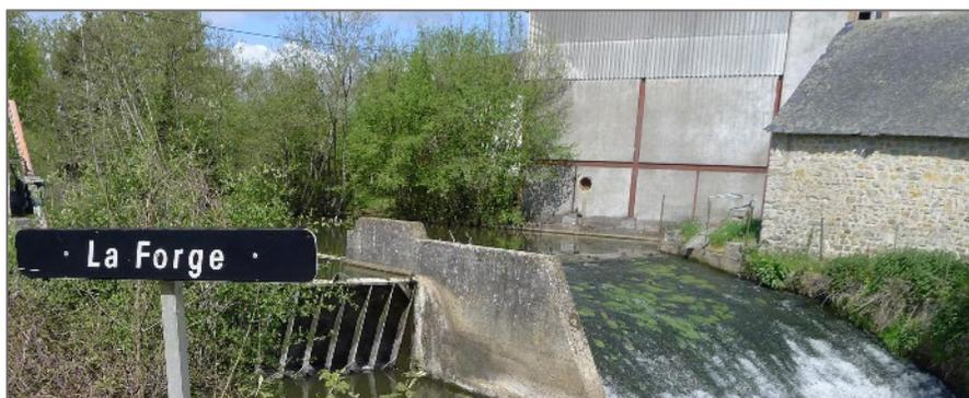
Figure 53 Barrage de "La Forge" à Andouillé, muni d'un déversoir. Les barrages entraînent la sédimentation des alluvions en amont et constituent parfois des obstacles à la circulation de la faune aquatique
