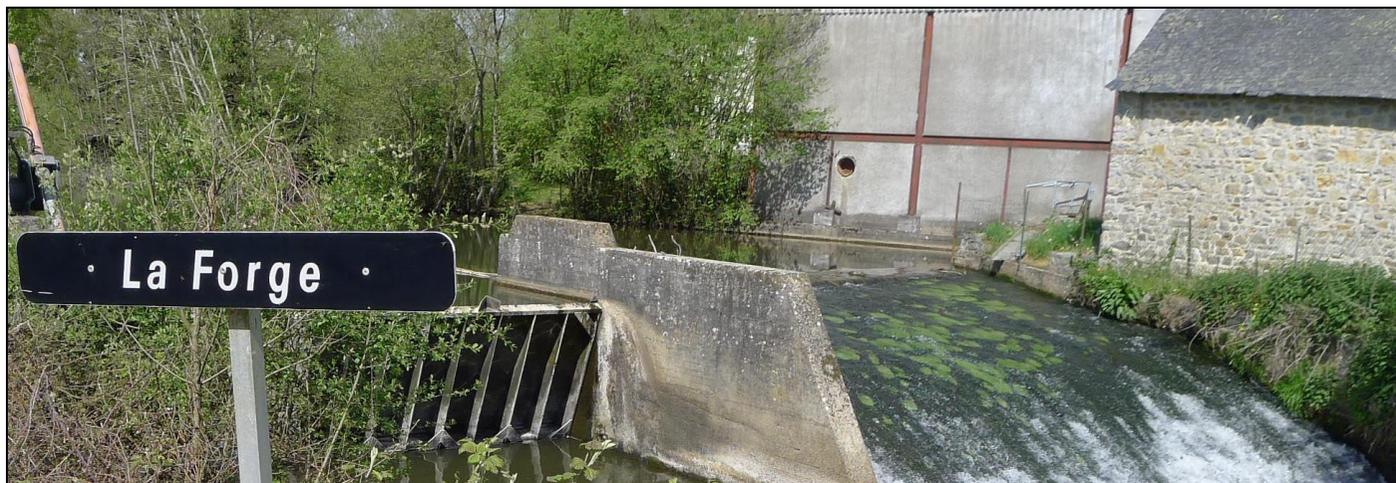
**Figure 70** Seuil de « la Forge » à Andouillé, sur la rivière l'Ernée. Quelques barrages subsistent, notamment autour d'Andouillé et sont référencés dans la liste des obstacles à l'écoulement (2015). Ils sont plus ou moins perméables à la circulation de la faune aquatique.
