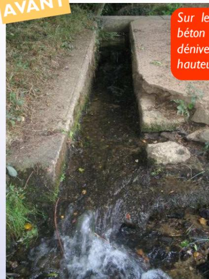
Sur le ruisseau de la Riautière, un plan incliné en béton empêchait la circulation des poissons avec un dénivelé de près d'un mètre en aval, une faible hauteur d'eau et des écoulements trop rapides.
