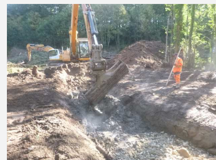
Travaux 2019 - Restauration de la rivière l'Ernée à la Forge de Montaudin
