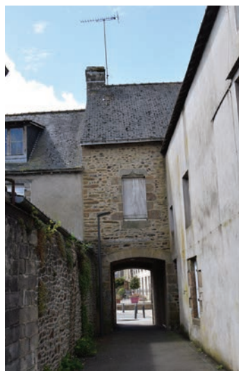
Passage Saint-Grégoire vu depuis le nord Cliché de C. Chauveau, Hadès, 2022
