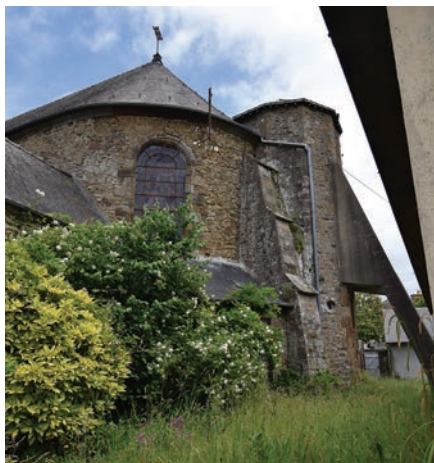
Tour octogonale située au chevet de l'église, vue depuis l'ouest, Cliché de C. Chauveau, Hadès, 2022
