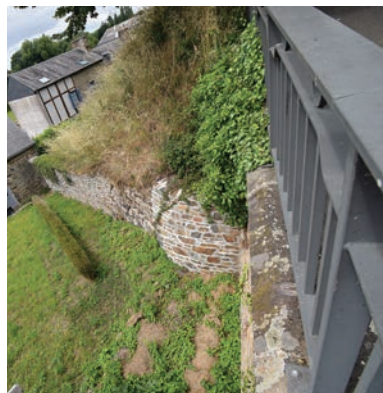
Maçonnerie située à l'ouest en contrebas de la rue de la Tranchée, comprenant une portion de mur de plan circulaire cliché de C. Chauveau, Hadès, 2022
