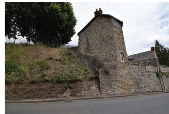
Façade Ouest de la maison située à l'extrémité sud de la rue de la Tranchée cliché de C. Chauveau, Hadès, 2022
