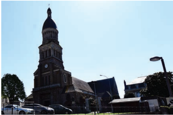
Église Notre-Dame vue depuis le nord-ouest, cliché de C. Chauveau, Hadès, 2022
