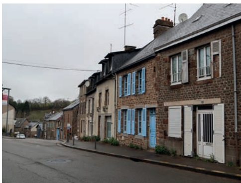
Rue Auguste Fortin (côté nord regardant au Sud)
