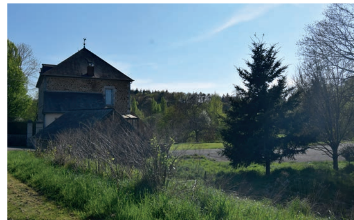
Ferme proche du cours d'eau
